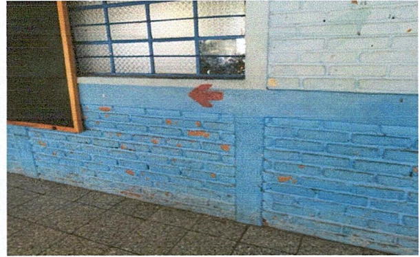
Foto 2: Pintura en muros interiores y exteriores
