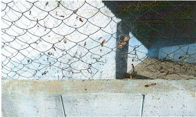
FOTO 3: Mejoramiento de malla del muro perimetral
